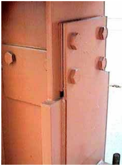
الشكل (2-1): وصلة عمود عن طريق براغي Bolted Column Splice
