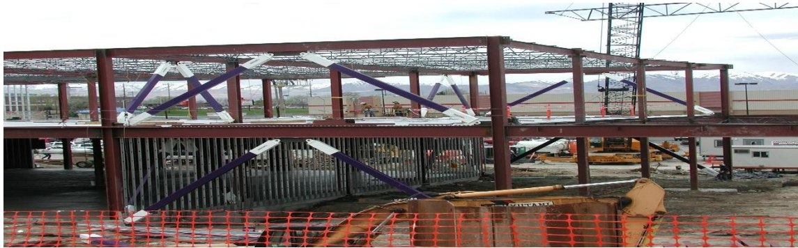
الشكل (1-7) : منشأة معدنية مزودة بعنصر تربيط ممنوع من التحنيب (Engelhardt,2007)
